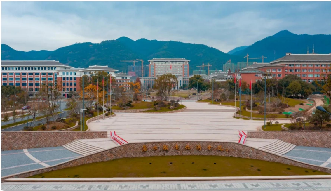
学校“南大门”竣工投入使用，美丽校园凸显城市客厅作用
