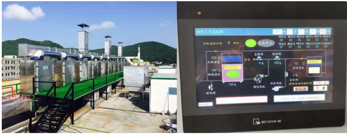
图6-1 校级科技创新团队为台州旭钧环保科技有限公司开发的智能型催化燃烧控制系统
