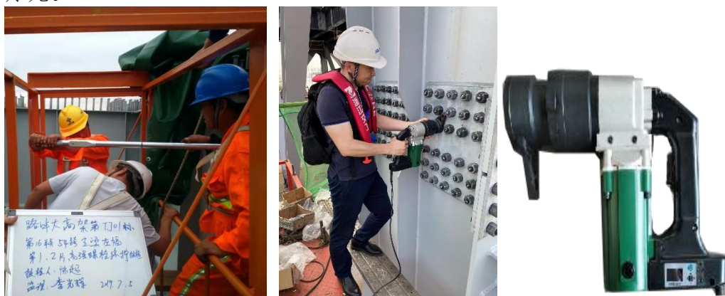
图 5-3 高强螺栓检查技术
