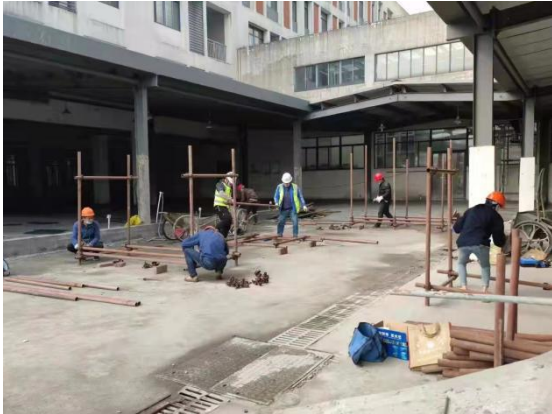
图-70 特种作业人员实操培训现场
